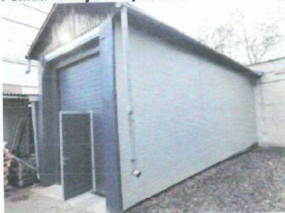
Pohľad na obj.č.7 súp.č. 4503, časť sklad sušeného mlieka
